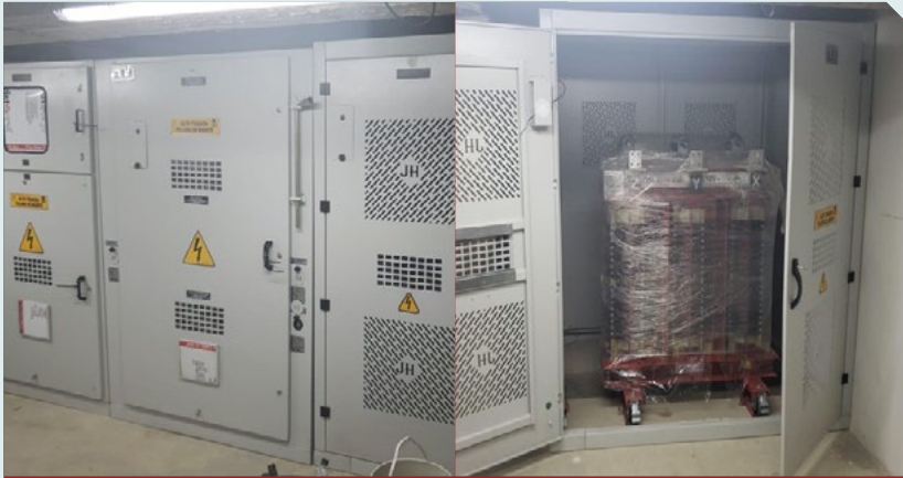
Figura 230. Montaje e instalación subestación eléctrica 225 Kva. Estado: En ejecución
