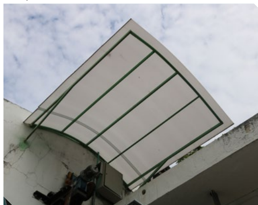
Figura 224. Suministro y montaje de cubierta. Bloque C sede Quirinal
