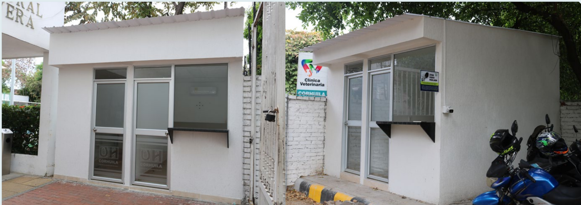
Figura 229. Construcción de dos casetas para ventanilla
