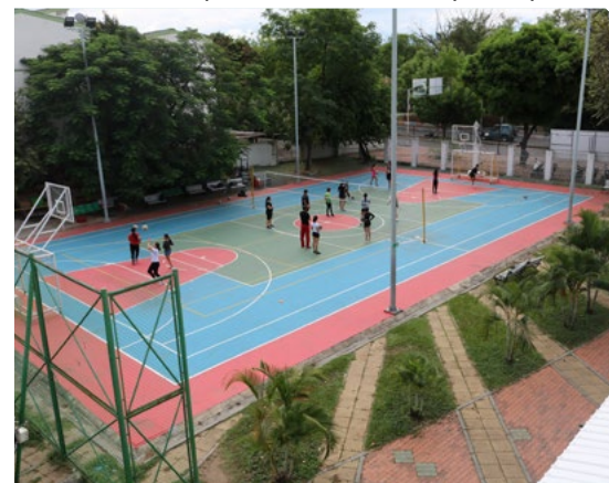
Figura 225. Suministro e instalación de sistema de recubrimiento para la cancha múltiple deportiva
