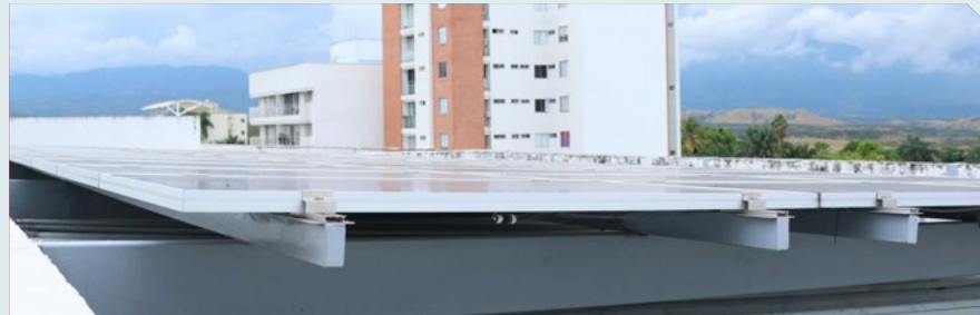
Figura 232. Reforzamiento de estructura que soporta los paneles solares
