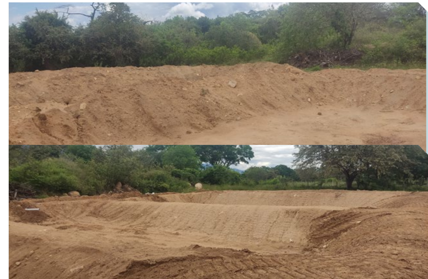
Figura 237. Construcción de 4 estanques piscícolas
