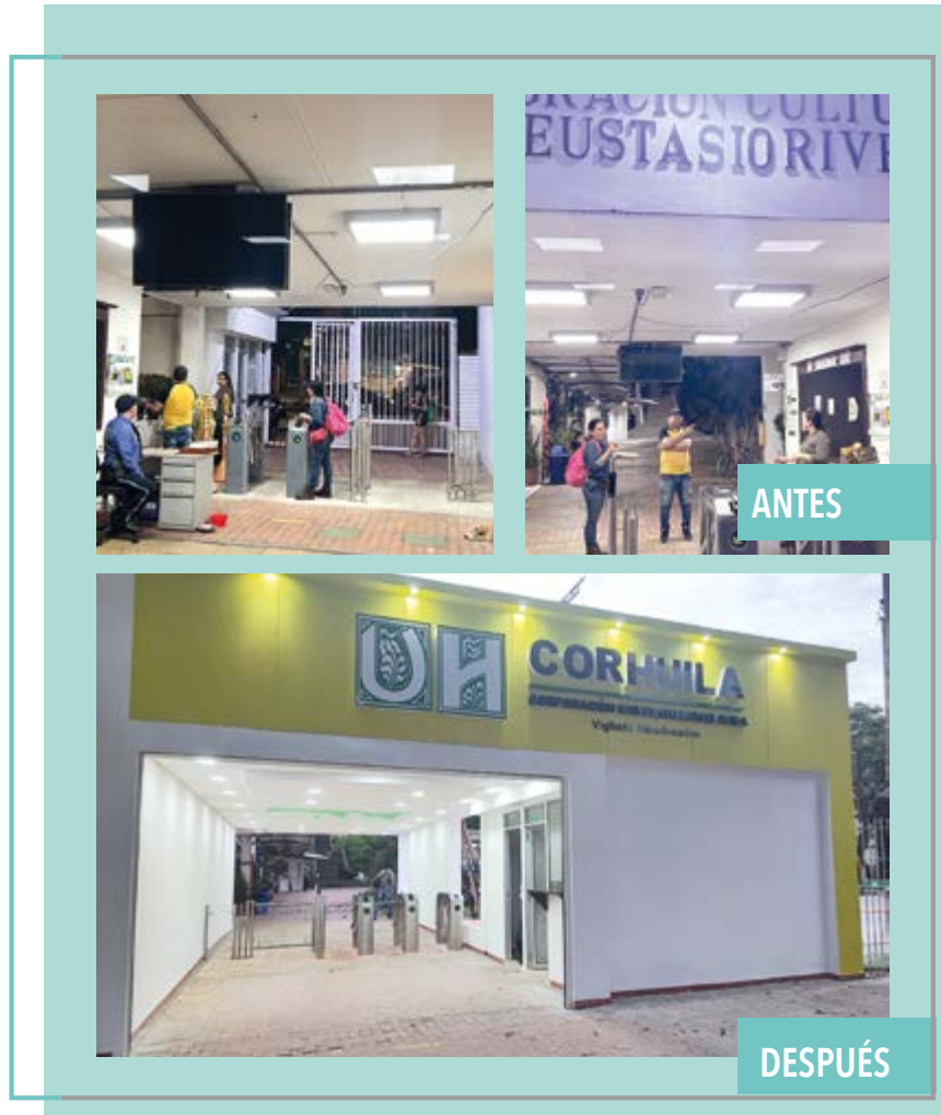
Figura 220. Construcción fachada principal CORHUILA.
