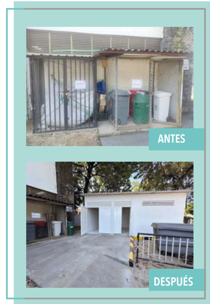
Figura 221. Construcción centro de acopio de residuos.
