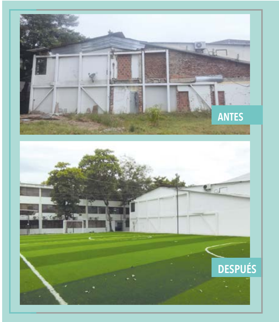
Figura 222. Construcción cancha de futbol 5 en grama sintética.
