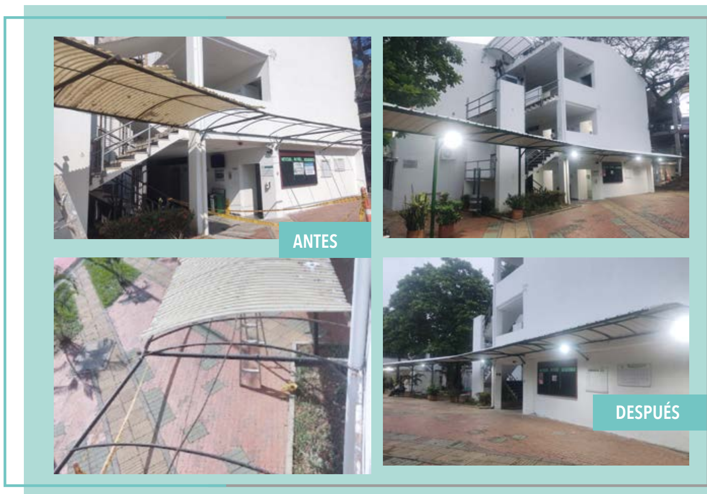
Figura 216. Cambio de cubierta corredor sede Quirinal.
