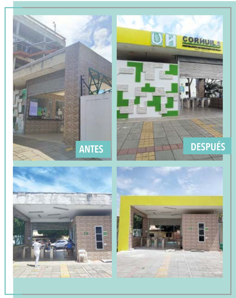
Figura 223. Adecuación de fachada principal, sede Prado Alto.
