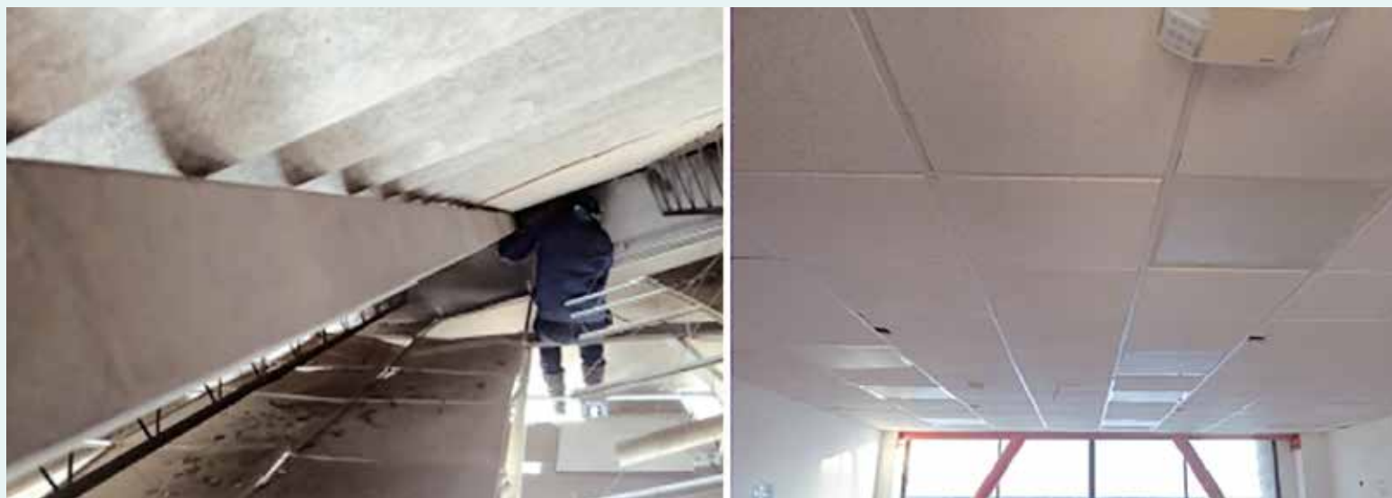
Figura 217. Reforzamiento estructural de cubierta del bloque B
