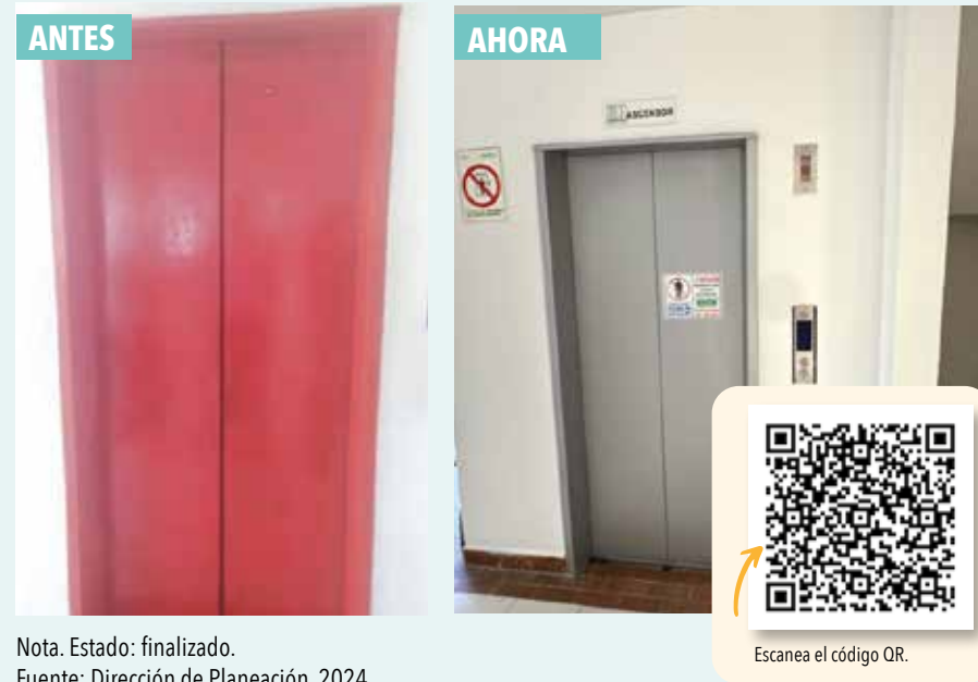
Figura 215. Instalación y montaje nuevo ascensor bloque C.
