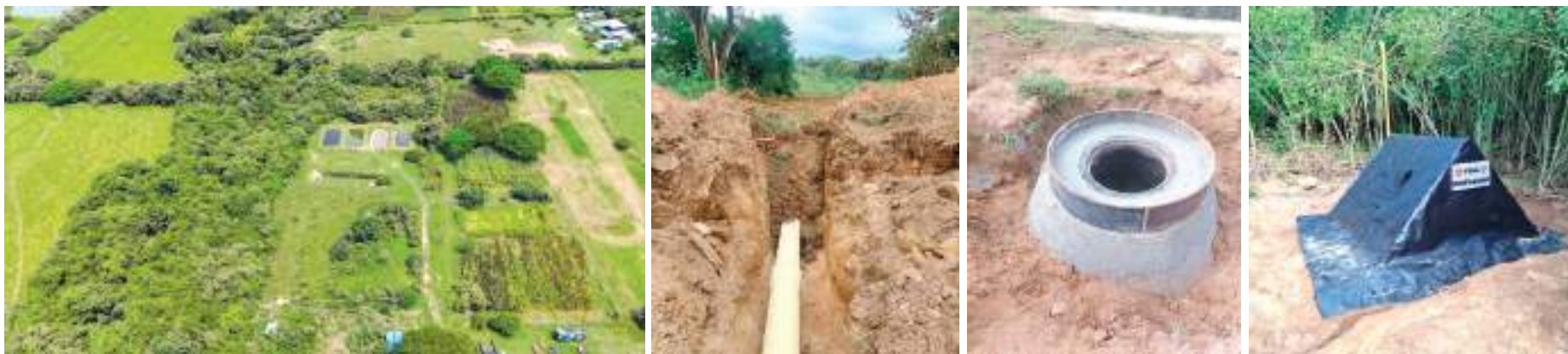
Figura 182. Obras finalizadas de adecuación del sistema de tratamiento de aguas de vertimiento y la construcción de las fosas de mortalidad, incluido el análisis técnico para la correcta ubicación del proyecto piscícola de la Granja Experimental de Rivera
