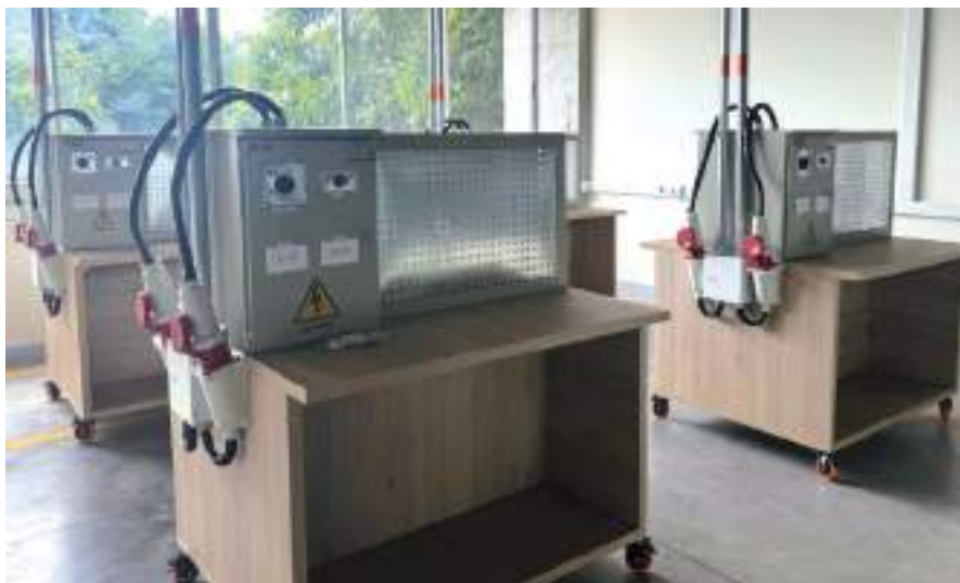
Figura 180. Adecuación finalizada de nuevo laboratorio de electricidad en el bloque de laboratorios
