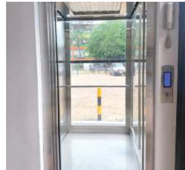
Figura 179. Montaje e instalación finalizada de nuevo ascensor del bloque C
