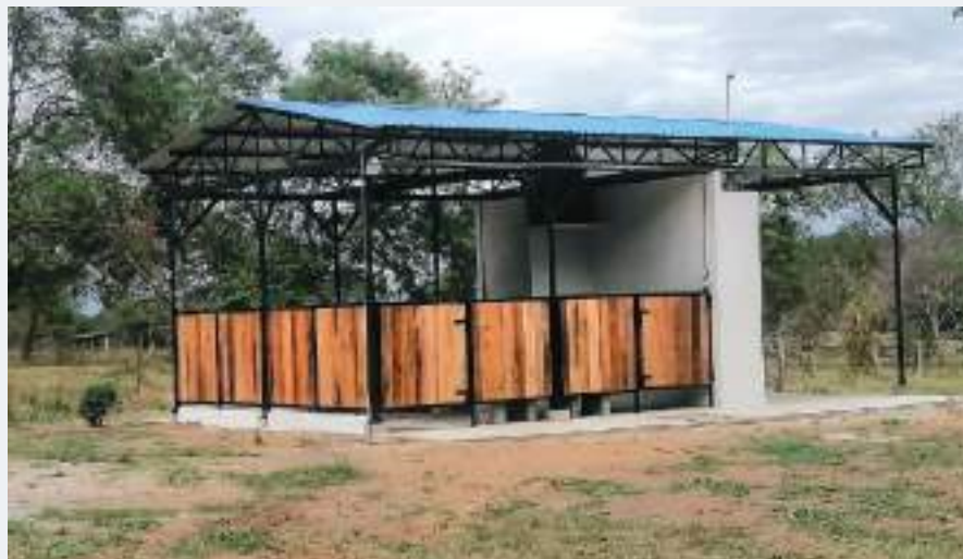
Figura 183. Construcción finalizada de cuatro pesebreras
